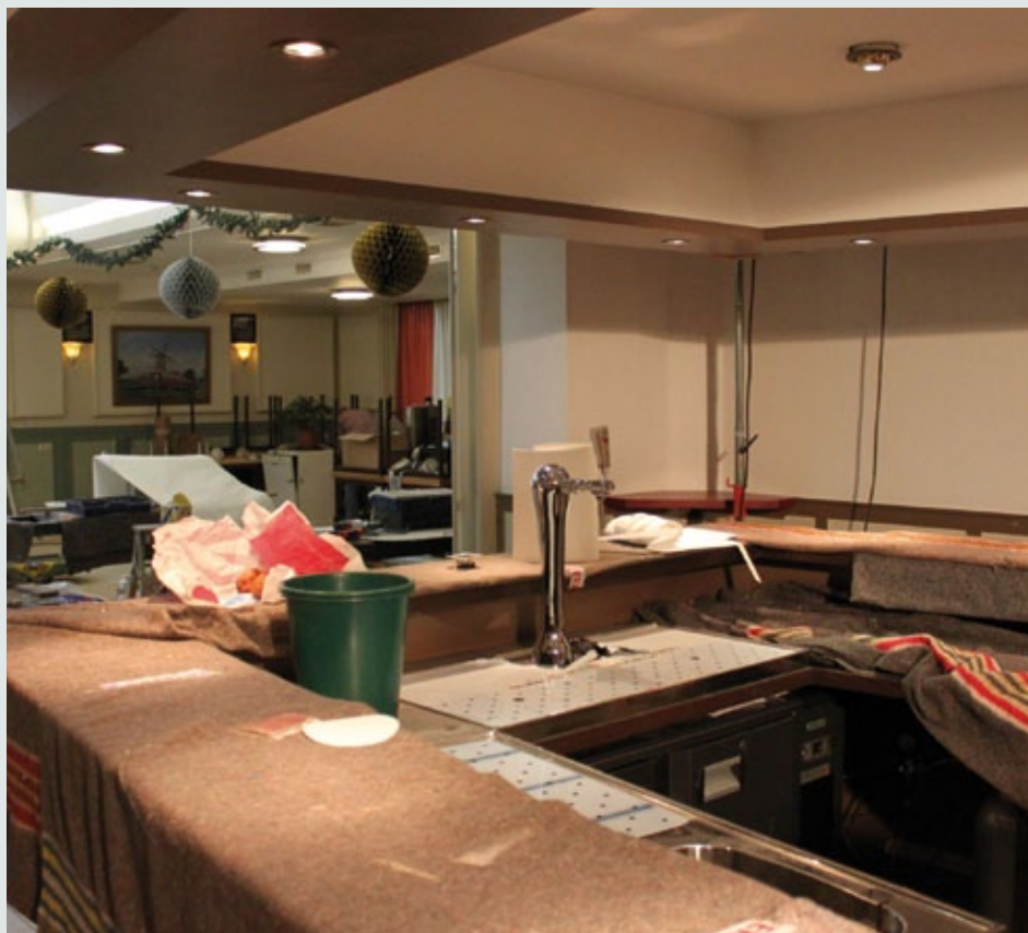
Werkzaamheden bij de nieuwe bar van het gildehuis.
