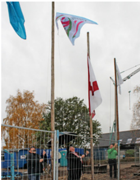
De officiële opening van de bouw door het hijsen van de vlaggen.
