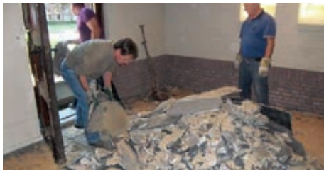
Oude vloer verwijderen.
